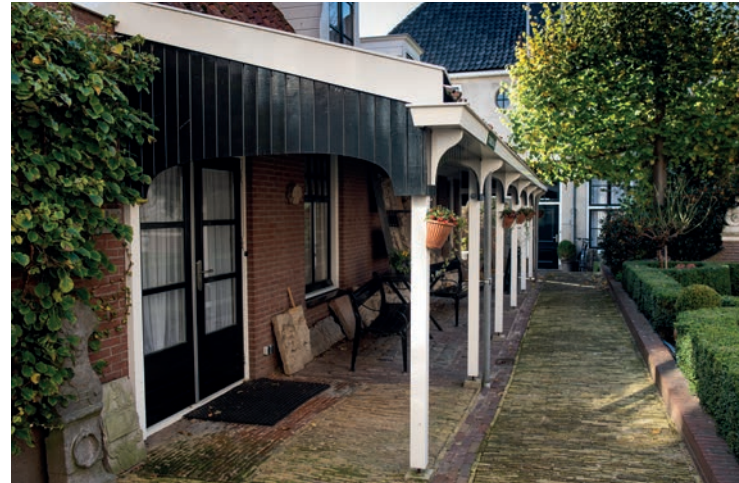
De houten luifel die de binnentuin omzoomd, kende relatief veel houtrot
