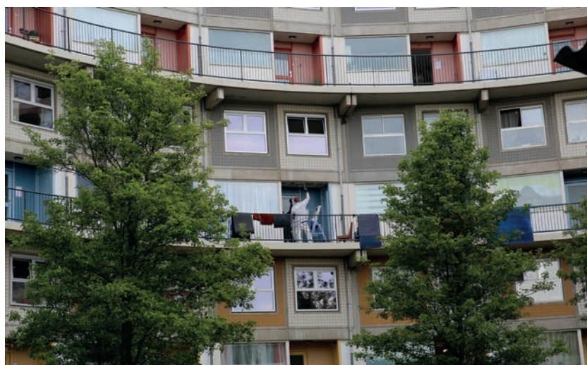
Bij het schilderwerk wordt rekening gehouden met de oorspronkelijke kleuren van het gebouw. Hier is een van de schilders bezig op de galerij
